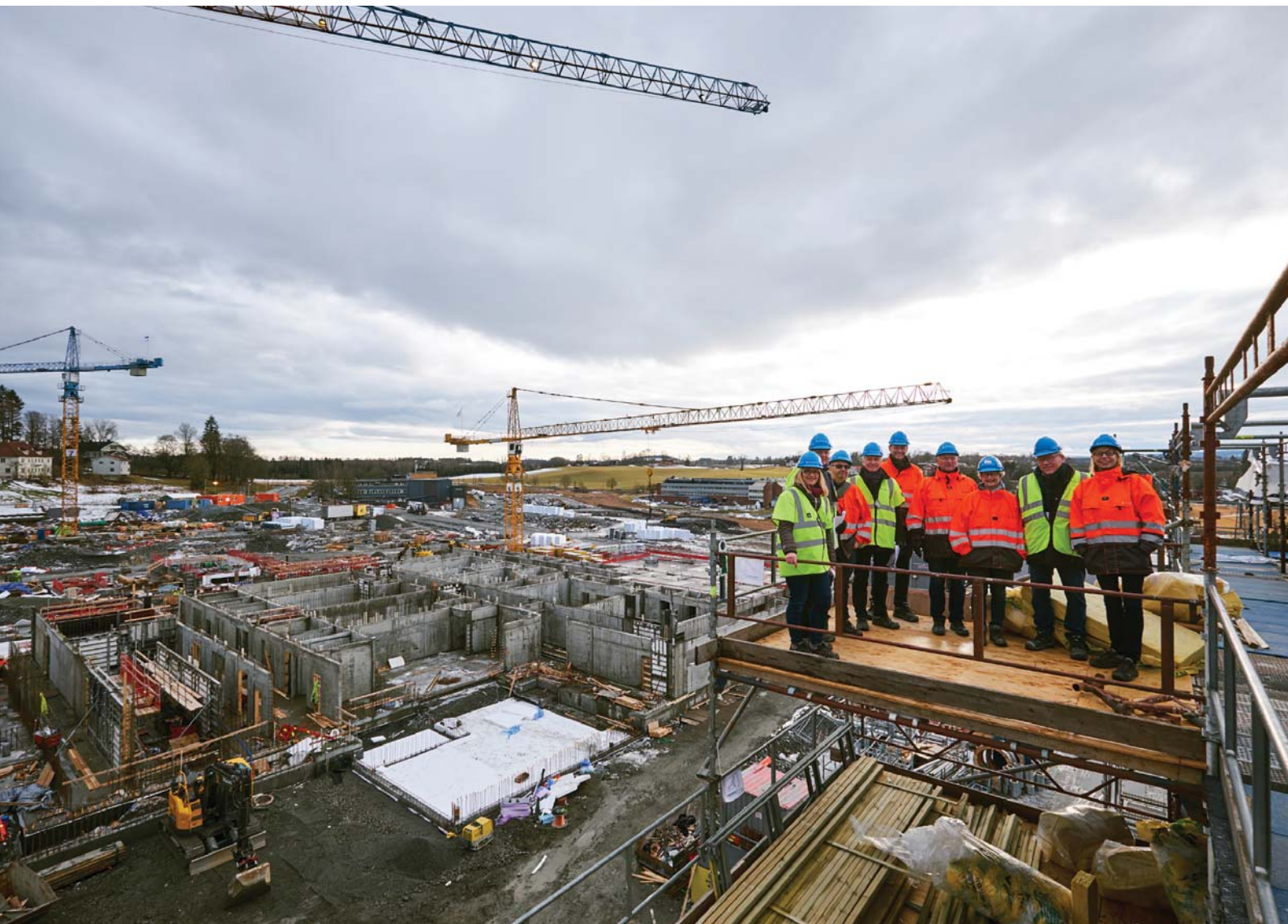
På befaring. Bildet viser bare tre av de syv heisekranene på området. En delegasjon fra Veterinærinstituttet blir vist rundt av representanter fra Statsbygg. Fra venstre: Mari M. Press, Gaute Lenvik, Asle Haukaas, Erik Antonsen, Jens Børsum, Per-Roar Nordby, Berit Djønne, Arne Schie og Eva Kvandal.
